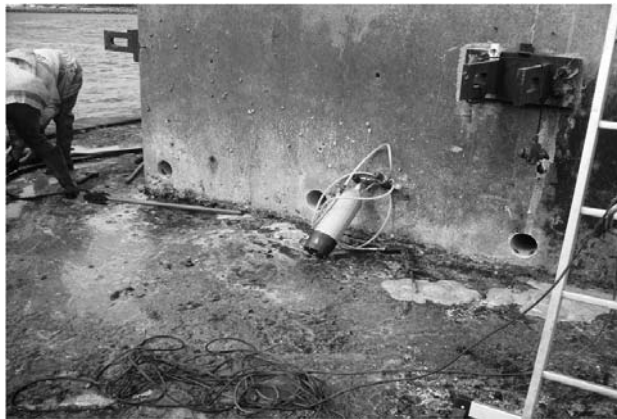
Figura 21. Refuerzo de la cimentación de las pilas laterales. Operaciones de perforación.
