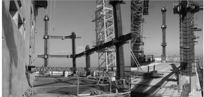
Figura 5 – Montaje de los pilares mixtos en la Torre de Cristal
