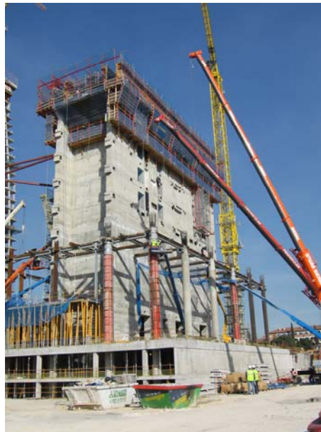
Figura 6. Construcción del núcleo central
