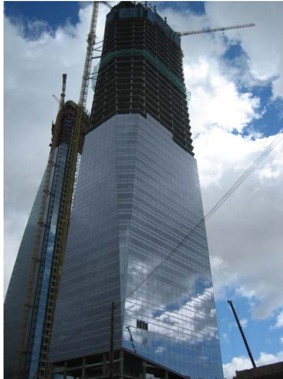
Figura 9. Inclinación de los pilares, por diseño de la fachada.
