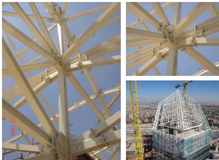
Figura 10. Estructura metálica de coronación.
