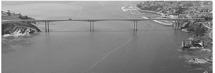
Figura 18. Vista general del Puente de Los Santos antes del comienzo de los trabajos de ampliación.
