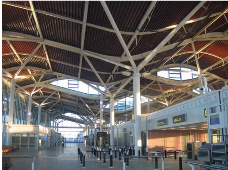
Fig. 2. Vista del espacio interior, Aeropuerto de Zaragoza
